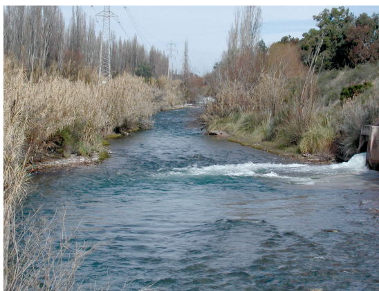
Figura 11. Tramo donde se ve el Zanjón no canalizado antes de su ingreso en la ciudad de Mendoza. Fotografía del autor.
